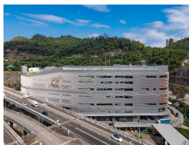
運輸署車輛檢驗 綜合大樓
